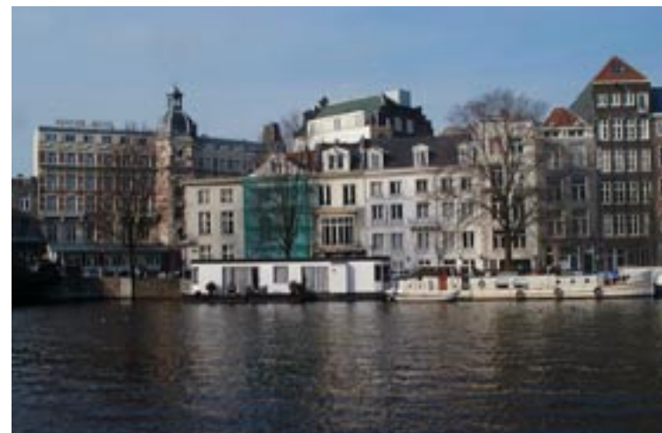
Ligplaatsen woonboten in de Amstel aan het 's Gravelandse Veer
