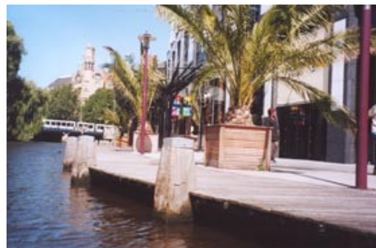
Openbare wandelsteiger in de Singelgracht ter hoogte van het Casino
